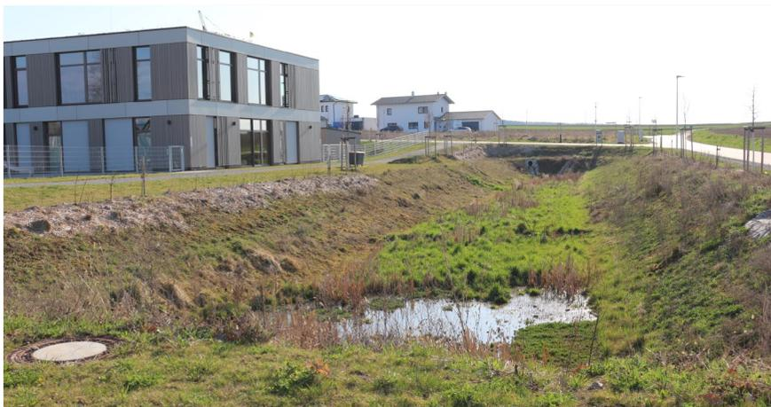
Regenrückhaltebecken spielen eine wichtige Rolle in der Oberflächenentwässerung, insbesondere im Hinblick auf nachhaltige und ökologische Lösungen für den Hochwasserschutz. Sie dienen dazu, Regenwasser zu sammeln und zu speichern, um die Abflussmenge während eines Starkregenereignisses zu reduzieren. Dadurch wird das
